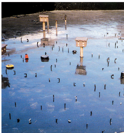
Body vodních objektů, ve kterých se nacházejí různá zařízení (věže, studánky atd.), potřebují přilnavost a dobré vyplnění spár mezi nerezovou ocelí, mědí, betonem či PVC.
