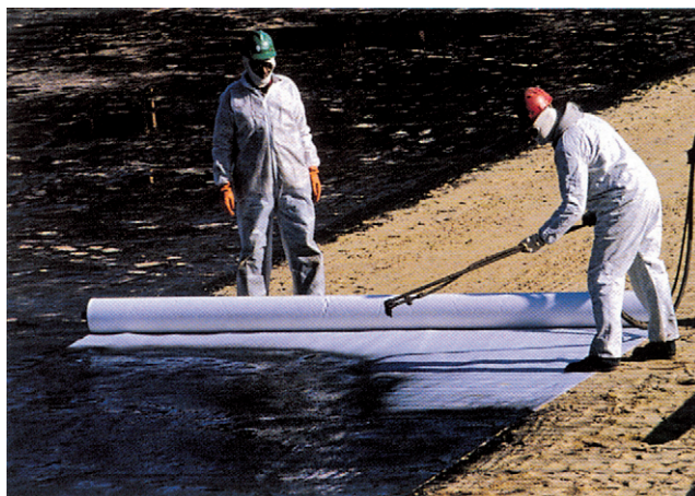
Příklad použití polyesterových tkanin s cílem zesílení podkladu povlaků CIM. Prodloužení tkanin může dosáhnout až 50 %.
