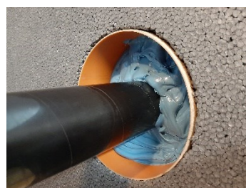
Aplikace Anticor Seal při průchodu základovým věncem
