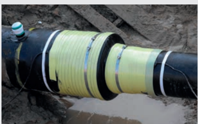
Utěsnění produktovodu v chráničce – smršťovací manžeta
