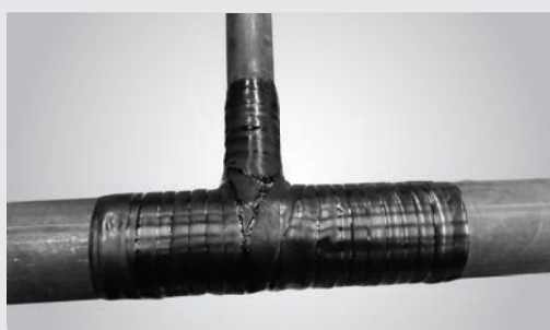
Montážní postup FLEXCLAD-II-C30 na T-kus
