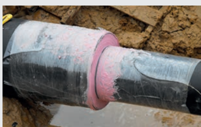
Utěsnění produktovodu v chráničce – gumová manžeta
