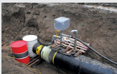
Montáž plnicího a odvzdušňovacího potrubí
