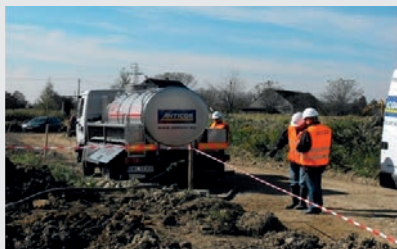
Transport materiálu a plnění chráničky
